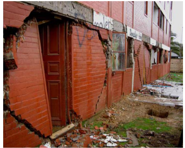
شکل ۳: عملکرد ساختمان‌های آجری کلافدار در زلزله سال ۲۰۱۰ شیلی، ساختمان سه طبقه، آسیب در طبقه اول [۶]
