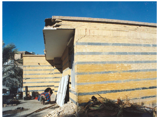
شکل ۲: آسیب دیدگی جزئی یک ساختمان آجری کلافدار (ساختمان منابع طبیعی بم) در زلزله ۲۰۰۳ بم [۱]
