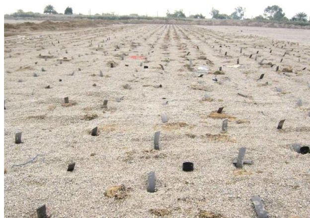
شکل ۶: نمای کلی از نصب و آرایش مثلثی زهکش‌های قائم در پروژه پیش‌بارگذاری واحدهای زلال‌ساز سربندر خوزستان
