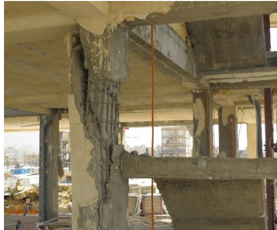
(الف) وقوع پدیده ستون کوتاه و تخریب ستون مجاور راه پله a. Short column formation and destruction of a column adjacent to staircase
