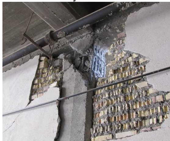
(الف) وقوع پدیده ستون کوتاه و تخریب ستون مجاور راه پله a. Short column formation and destruction of a column adjacent to staircase
