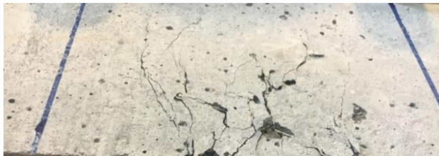
شکل ۷. پل زنی ترک
