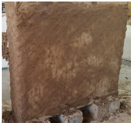
شکل ۵. اندودکاری دیوار با ملات کاهگل Fig. 5. Plastering with thatch mortar
