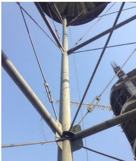
شکل ۲. اتصالات به کار رفته در مخزن هوایی آب
