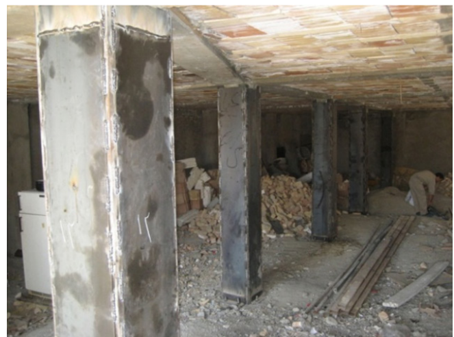
شکل ۱. مقاوم سازی ستون‌های سازه با ژاکت فولادی
