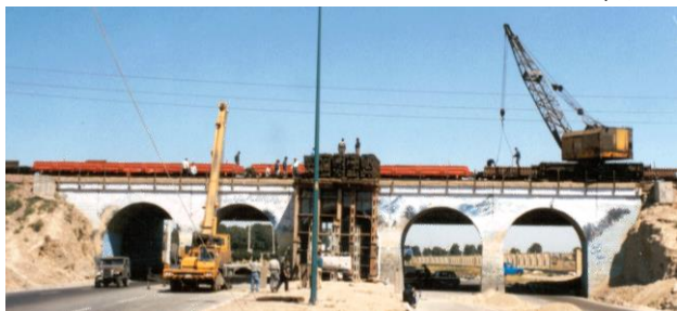
شکل (۲): آزمایش بارگذاری پل اکبرآباد
