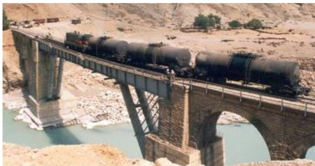
شکل (۱): آزمایش بارگذاری پل تله زنگ
