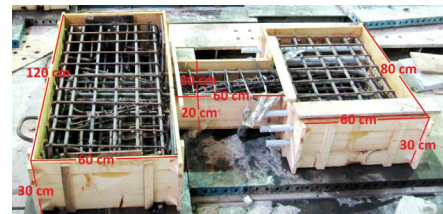
ب: نمونه آزمایشگاهی ساخته شده آماده بتن ریزی
